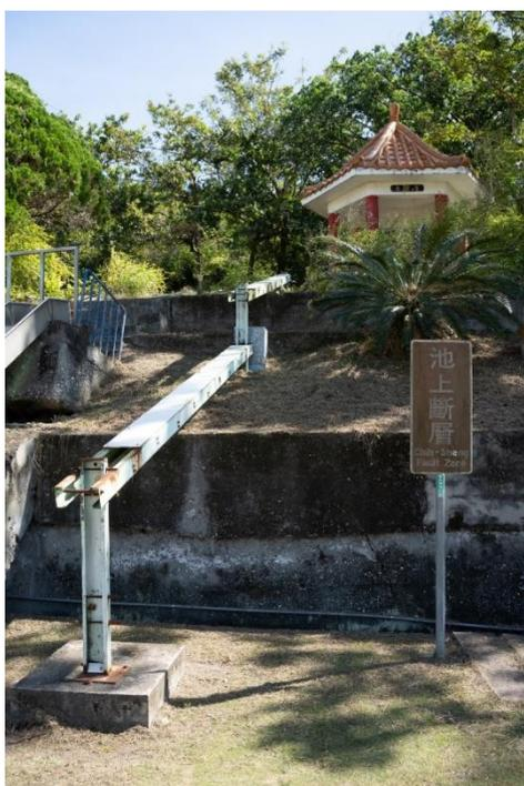
池上斷層沿著海岸山脈的山腳下出露。大坡國小操場東側的小山丘即是屬於海岸山脈，因此沿著斜坡底部，即是池上斷層的地表出露地點。在大坡國小校園可以觀察到一些受斷層擠壓抬升的地表破壞現象：例如，滑梯頂部翹起、斜坡底部擋土牆破裂。
